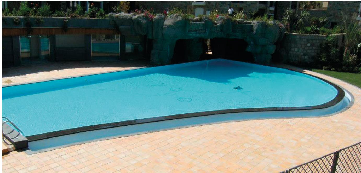
**ESP** El Liner es una membrana de PVC que se utiliza para impermeabilizar piscinas. Su uso está ampliamente extendido tanto en piscinas nuevas, con cualquier tipo de estructura, acero, plástico, hormigón, bloques, como en la reparación o rehabilitación de piscinas que pierden el agua. Se trata de un material dúctil, flexible, de tacto agradable y seguro en todos los sentidos.
