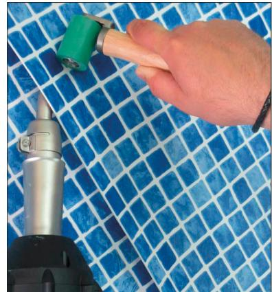
**ESP** La instalación del LINER ARMADO de PVC es compatible con cualquier tipo de superficie de la piscina: hormigón, gresite, azulejo, pintura y poliéster. Además, al ser un material flexible se adapta fácilmente al vaso de la piscina.
